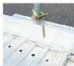
幅木固定金具の取付状況
