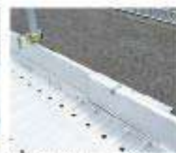
LB4572幅木の固定状況
