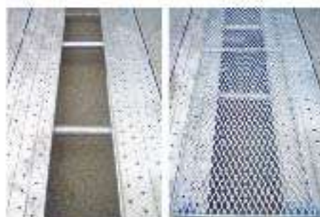
足場板を並べた隙間
