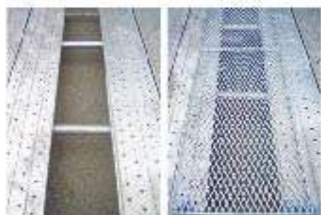
足場板を並べた隙間
