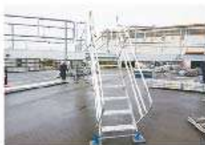
昇降階段設置状態
