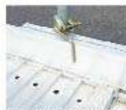
幅木固定金具の取付状況
